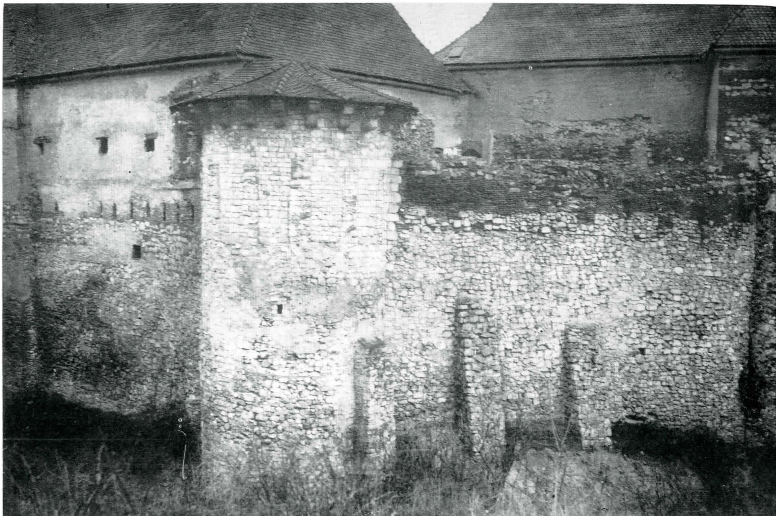
Fig. 8. Vedere generală a colțului de sud-est al castelului. Se văd „Turnul Pustiu” (cu urmele crenelurilor) și curțina exterioară datată pe la 1442.
